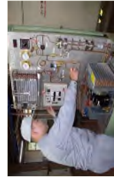
▲ ビル管理技術科 (冷凍空調機運転・調整実習)
