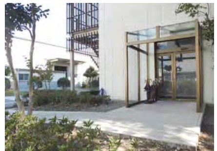
以前、壁であった場所を工事し、 自動ドア・スロープを設置
