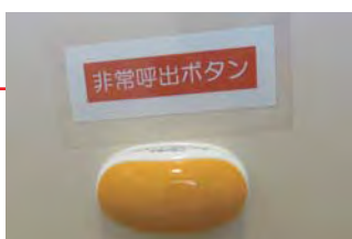
職場から離れたトイレに 非常呼出ボタンを設置
