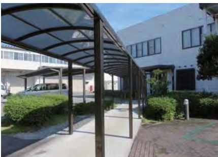
食堂につながる屋根付きスロープ
