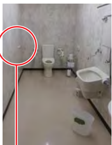
多目的トイレ1
