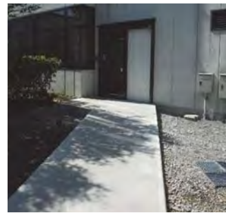
自動ドア・スロープの設置
