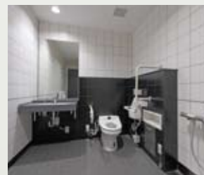
シャワー付きの多目的トイレ
