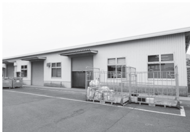
パソコン機器の解体・選別が行われている建屋
