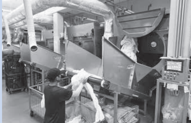
大型の全自動連続洗濯機からリネン類が送り出される
