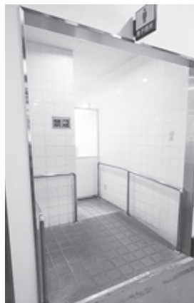
更衣室やトイレには、スロープや手すりを取りつけられている
