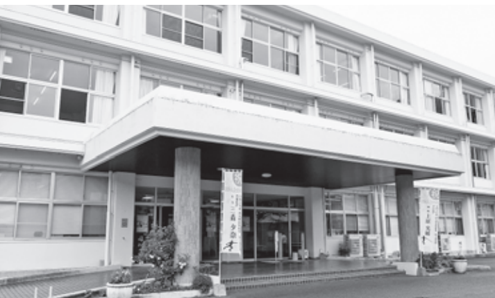
併設する宮崎県立延岡商業高等学校 (宮崎県立延岡しろやま支援学校延岡商業校は、この教育棟の1階)
