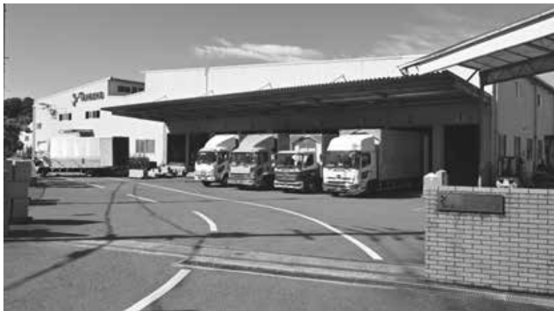
株式会社タカショー 中央ロジスティックセンター
