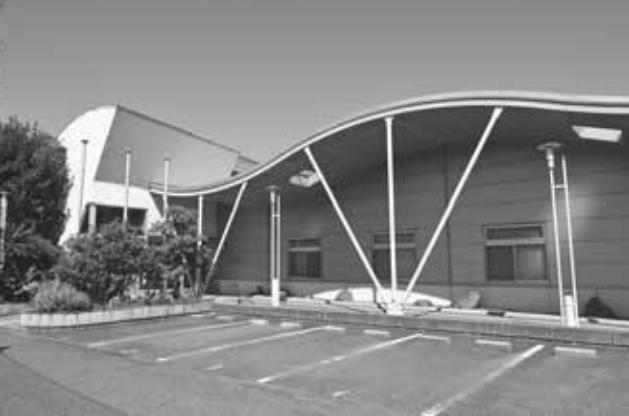
株式会社かんでんエルハート本社
