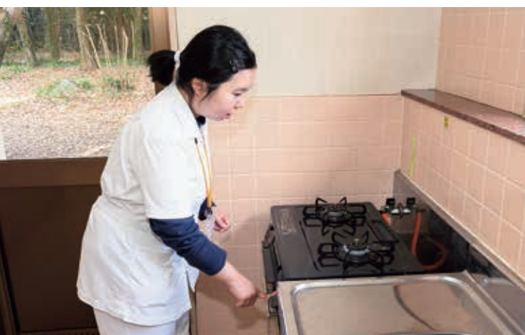
炊事場の清掃では、月に一度、ガスの点検を行う。 コンロの点火状況を確認する
