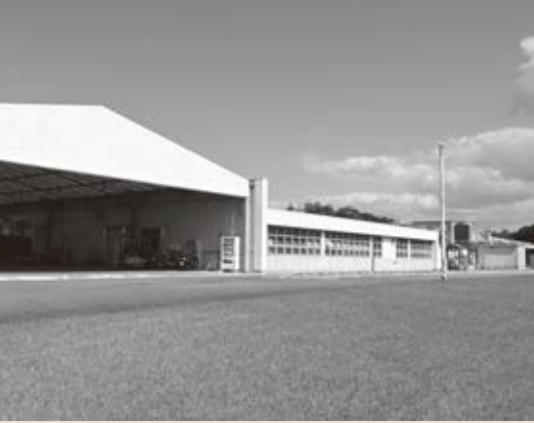
株式会社キューサイファーム島根本社工場
