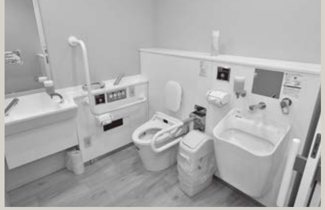
増設されたトイレには、社員の声を取り入れた
