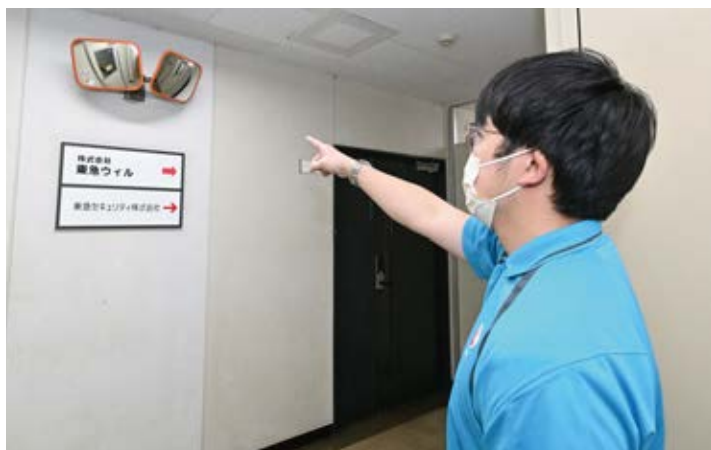
建物内の見通しが悪い場所にはカーブミラーが設置されている
