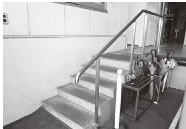
階段に設置された手すり
