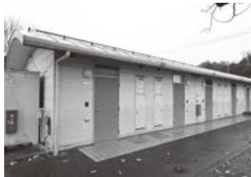
ワンルームタイプの部屋が5室設けられた「生活訓練棟」
