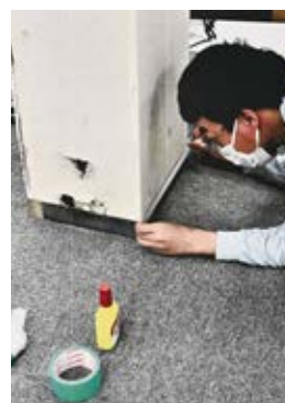
「壁の修理はおまかせ」 西田 賢一(にしだ けんいち 大阪府)
