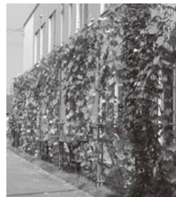
社屋の壁面に設けられた グリーンカーテン（写真提供： フジコーポレーション株式会社）
