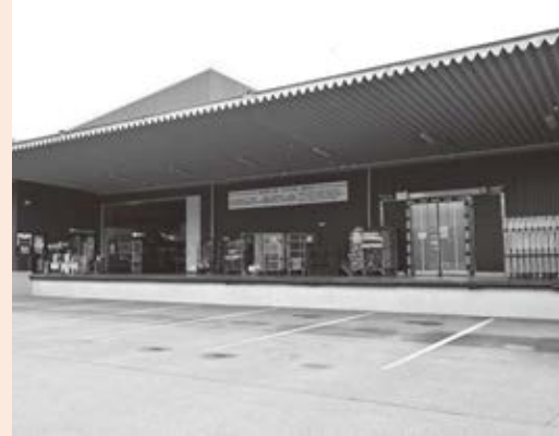
菊池ロジスティックセンター
