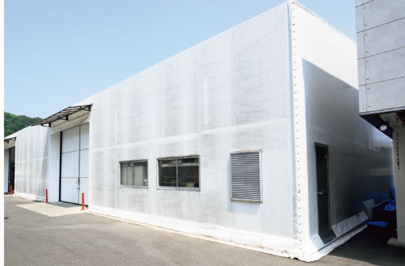
株式会社輝城の倉庫。同社では、このような テント生地を使用した建造物の設計や施工も手がけている
