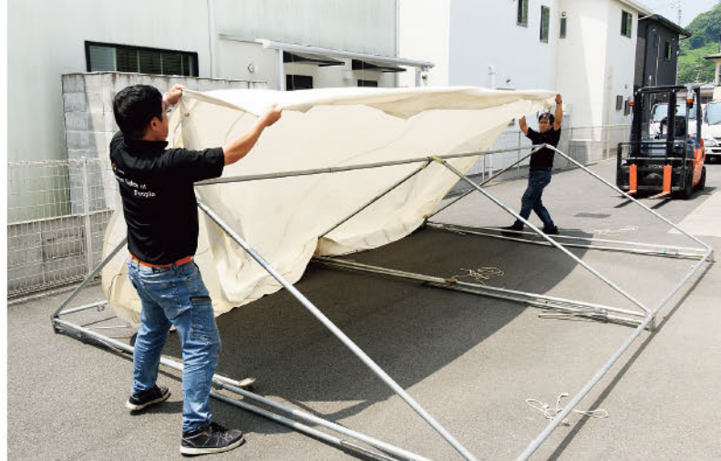
地鎮祭で使用するテントの設営作業を再現してもらった。 武智さん(左)と森田さん(右)が協力し、手際よくテントを組み立てていく
