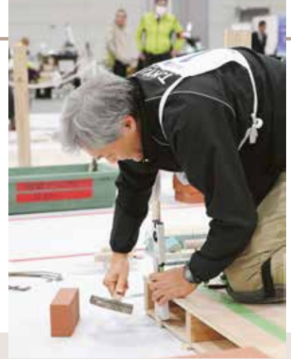
タイルを張る基準となる墨を打つための定規を土台に固定する。仕上がりの精度を左右する工程だ（写真提供：中央職業能力開発協会）
