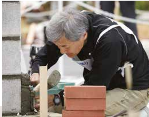
技能グランプリでの積み上げ張りの様子。糸を張って基準を定め、タイルの裏にモルタルを盛り、糸に合わせて1枚ずつ張っていく（写真提供：中央職業能力開発協会）
