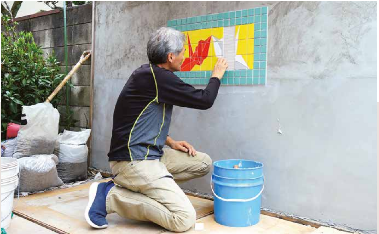
技能グランプリの課題を20回以上練習して本番に臨んだ。接着剤を塗ってから20分ほどで表面が乾いてしまうため、段取りを組んで一気に張る必要がある
