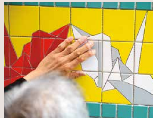
タイルをすべて張り終わったら、目地の幅が均等になるように調整を行う。接着剤が乾くまでにやり終える必要があり、時間との戦いでもある
