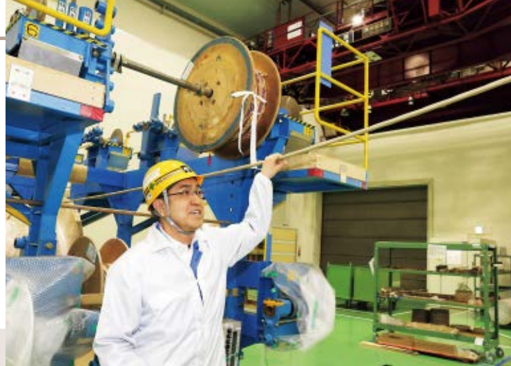
61ページ写真の右奥には、電線ドラムが設置された架台がある。そこから自動で送られてくる電線の張り具合を調整しながら巻いていく
