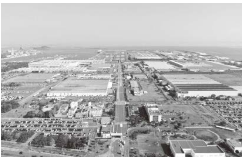
日産自動車九州株式会社の工場全景
