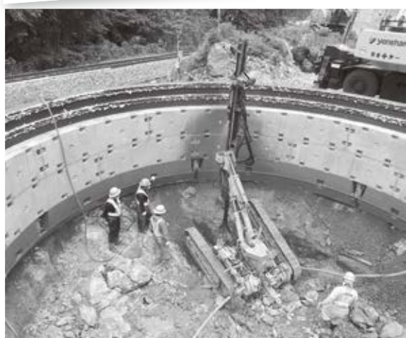
建物の重量を地中の支持層に伝達する杭を、地中深くに施工する大口径深礎工法
