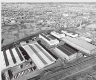
浜松市浜北区に建つ本社全景
