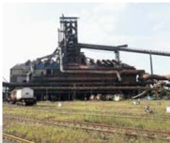
鉄鉱石から鉄をつくる高炉。君津地区では高さ125mの巨大高炉が2基稼働している
