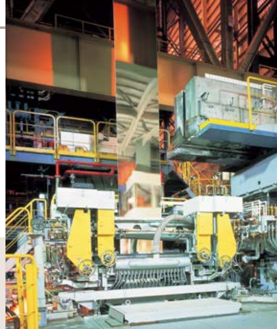
溶融めっきライン。見えない下部に炉やインダクタがある (写真提供：日本製鉄株式会社)
