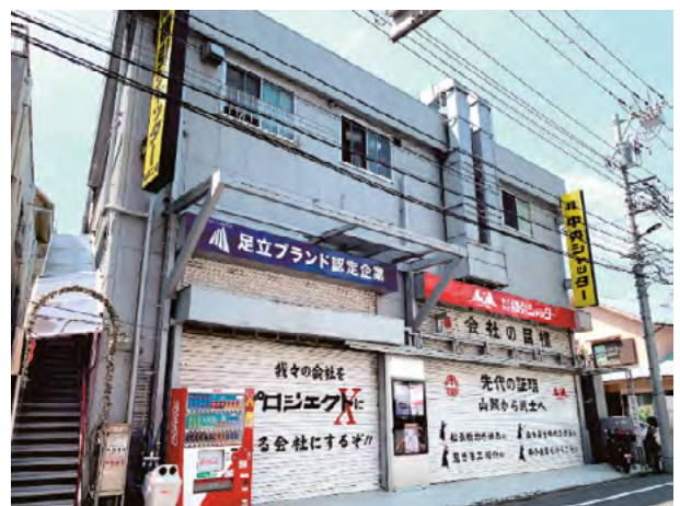
<株式会社横引シャッター 外観>
