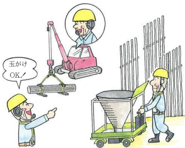
[ヘッドホン型無線機を使った指示] [バッテリー式コンクリートホッパー]
