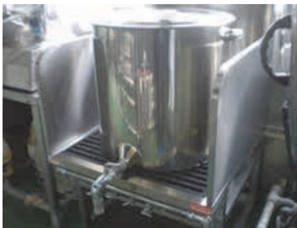
写真 15 改善後の給湯器
