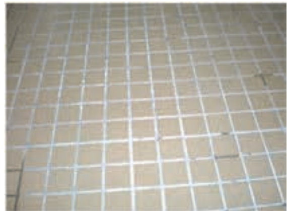
写真11 改善後の滑り止め加工された浴室床
