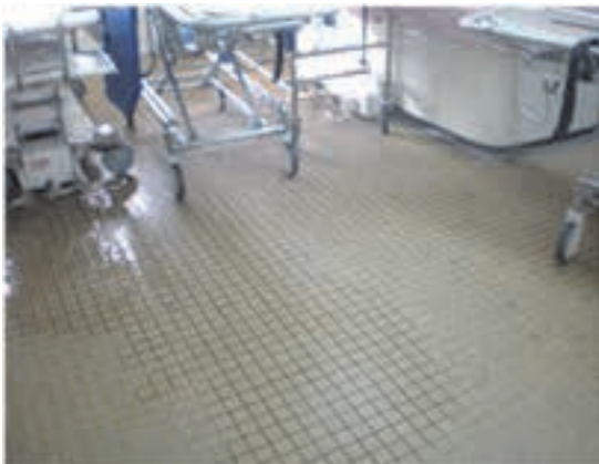
写真10 改善前の浴室床
