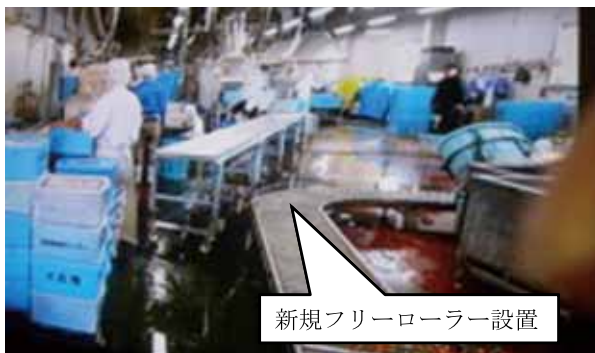
写真27 洗浄機のコンベア搬入口
