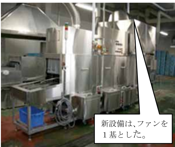
写真2 洗浄機改善後
