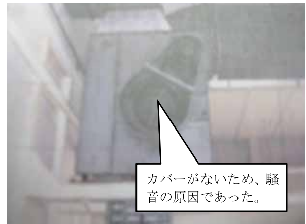
写真3 排気ファン改善前
