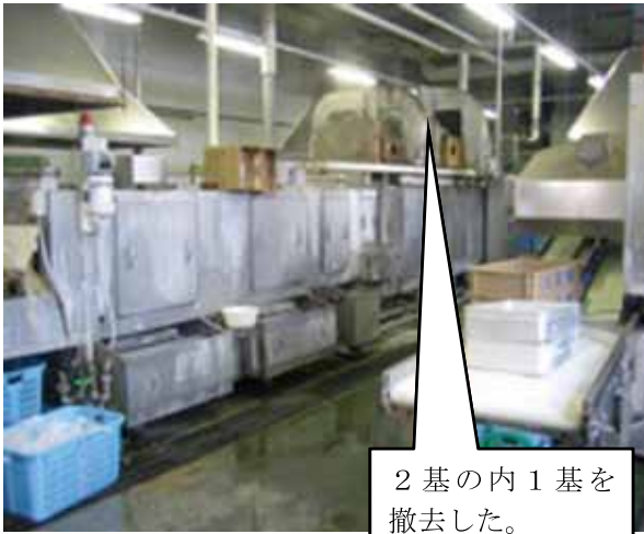
写真1 洗浄機改善前
