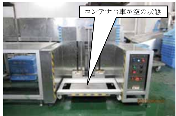
写真24 洗浄機の搬出口（改善後）①
