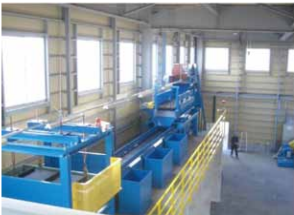
写真3 支援機器全景
