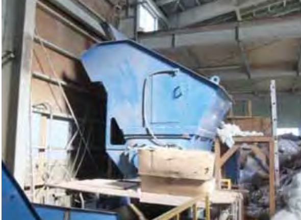
写真5 導入前の投入破碎部
