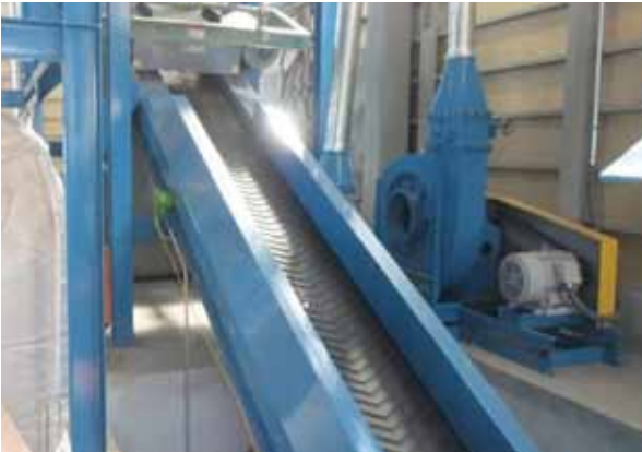
写真11 支援機器投入部
