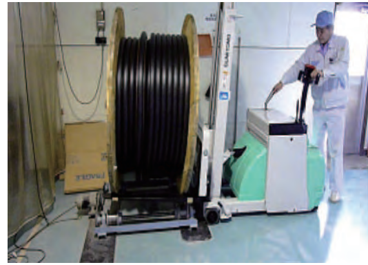
改善後・ケーブルリール設置
