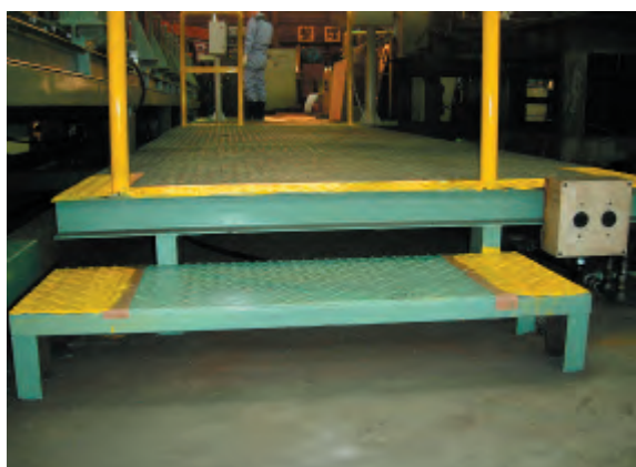
図-III-9 2段目の高さに併せた作業床
