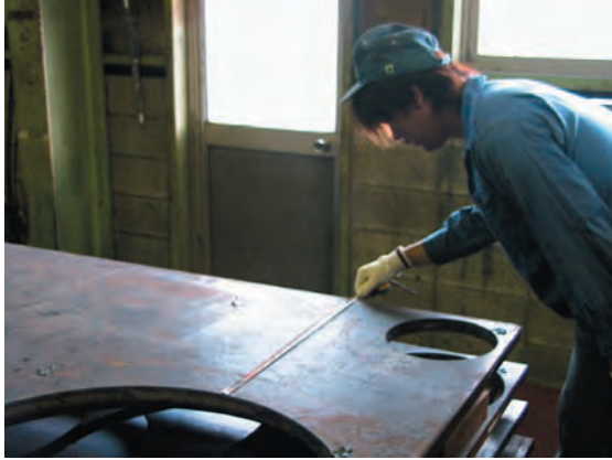
写真－4 鋼板の寸法取り作業
