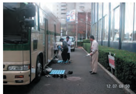
写真 2-5：レントゲン車設置
