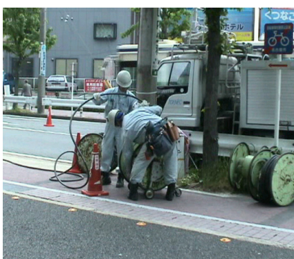
写真3 現行ケーブル巻取り作業
