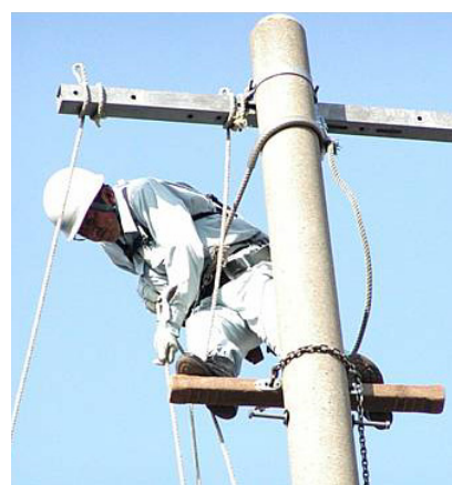
写真 6 仮足場を使用した作業
