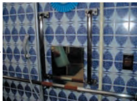
写真4-(2) 洗い場B (手すり設置後)
