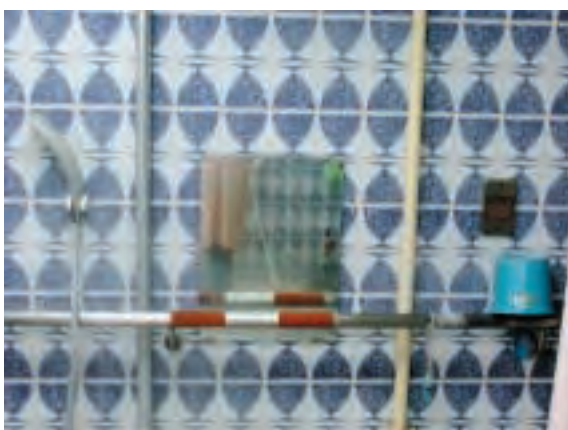
写真4-(1) 洗い場B (手すり設置前)
