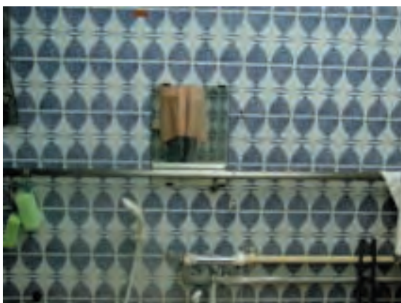
写真3-(1) 洗い場A (手すり設置前)
