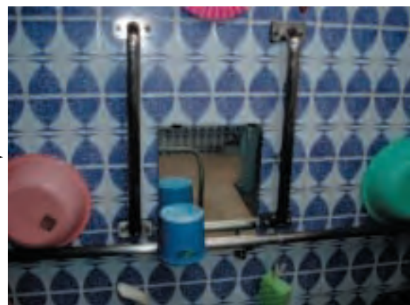
写真3-(2) 洗い場A (手すり設置後)
