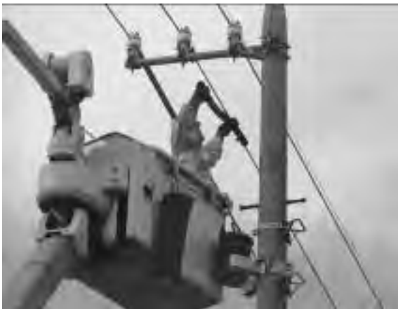
写真2 活線作業（防護取付け）
