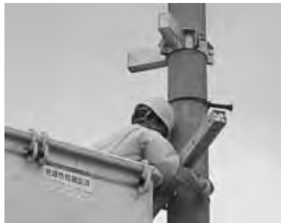
写真3 装柱作業（金物取付け）
