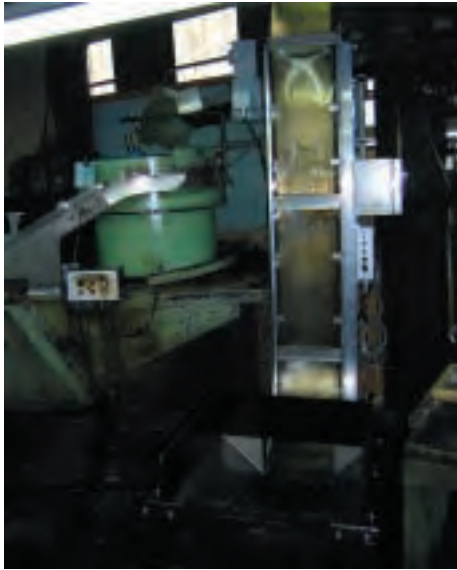
写真9 支援機器の設置状況
