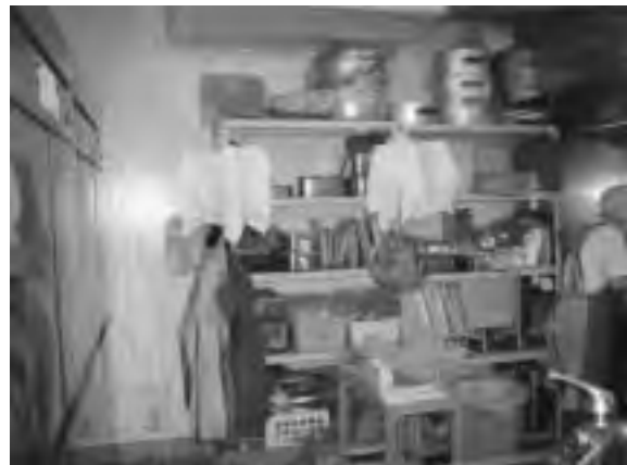
写真6 場所が狭いため収納棚の前が物置になっていて乱雑であり危険である。物の出し入れもしにくい。
