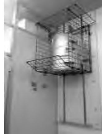
写真10 収納昇降機と取付け状況
