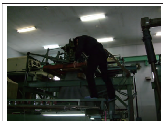
柄出し装置修理状況
