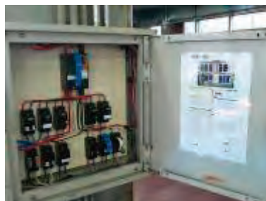
図表Ⅲ-47 照明の増設
