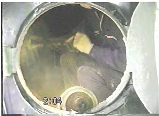
現状横引きダクト内清掃風景
