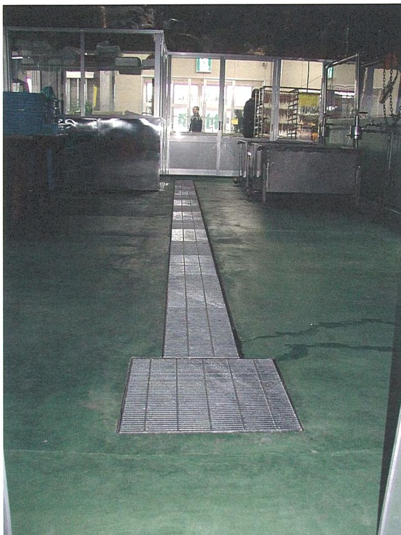
写真5 床面に設けられた排水溝（ボイル加工室の例）
