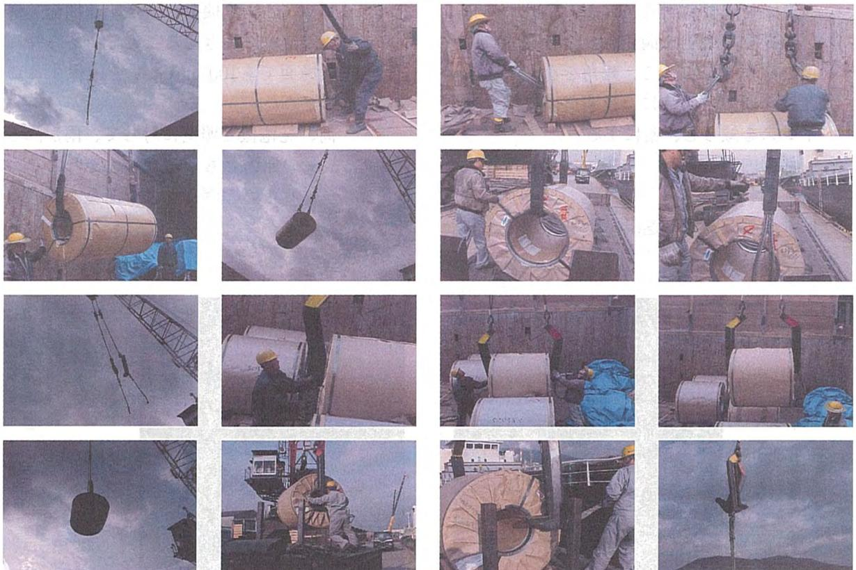
写真3 コイル状鋼板荷役作業（改善前）
