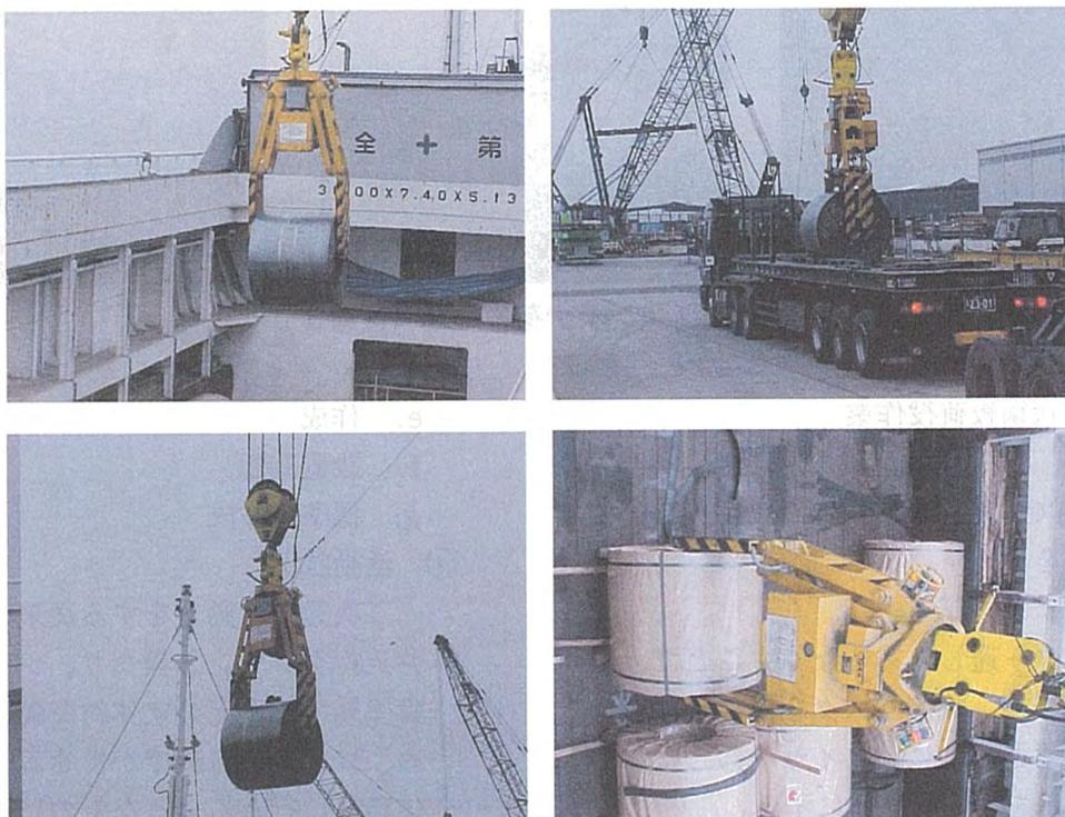
写真4 コイル状鋼板荷役作業（改善後）
