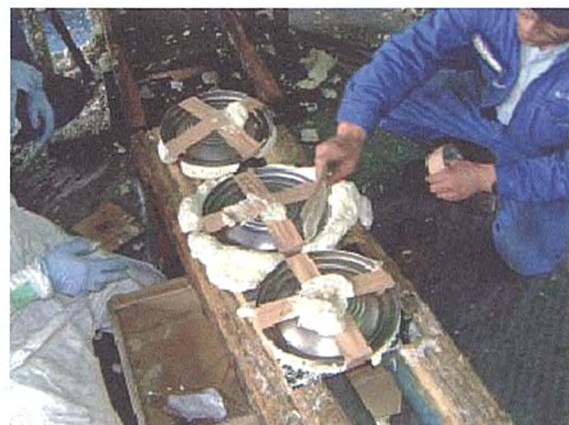
写真12 ウレタン塗布状況
