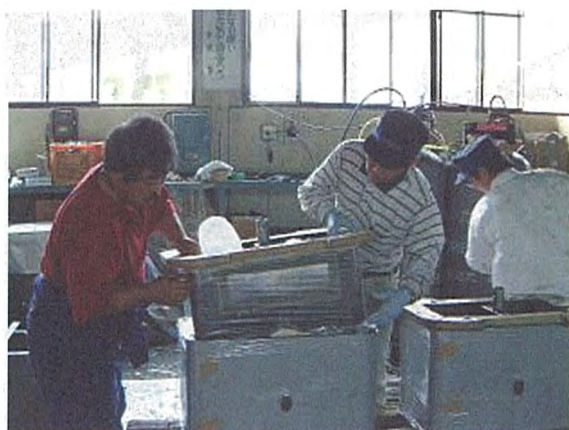
写真10 型枠組み込み作業
