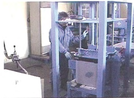
写真23 ウレタン注入作業の改善前・改善後
