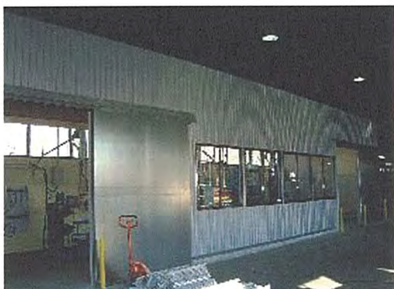
写真21 新設したウレタン温度条件安定化のための作業場
