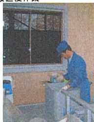
溶接直後作業
