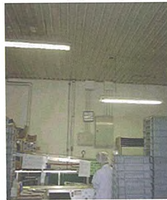
改善後：天井の水銀灯の移設及び手元灯への減光カバーの取り付け
