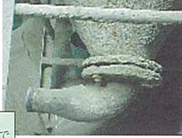
鉄鋼製のホッパーであり、写真のように腐食すること、下部がL型になっており、ここに耐火材が滞留しやすくなっている
