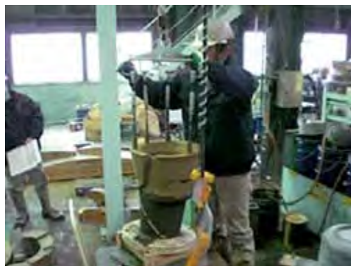
写真-11 使用時外観
