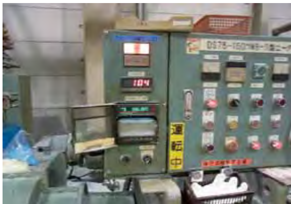
写真5 混練り温度の監視
