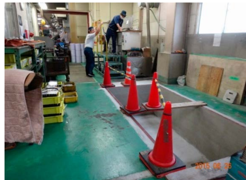
写真 41～42 洗浄装置を移動させ、床下設置のための床下掘り下げ工事
