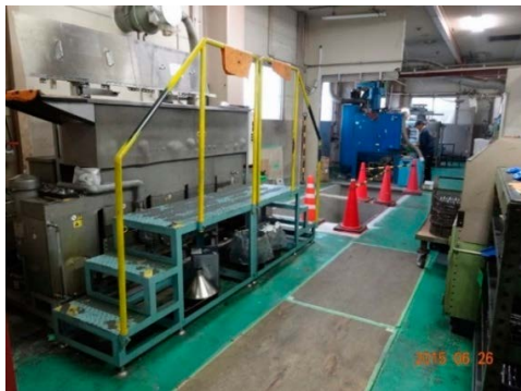
写真 41～42 洗浄装置を移動させ、床下設置のための床下掘り下げ工事
