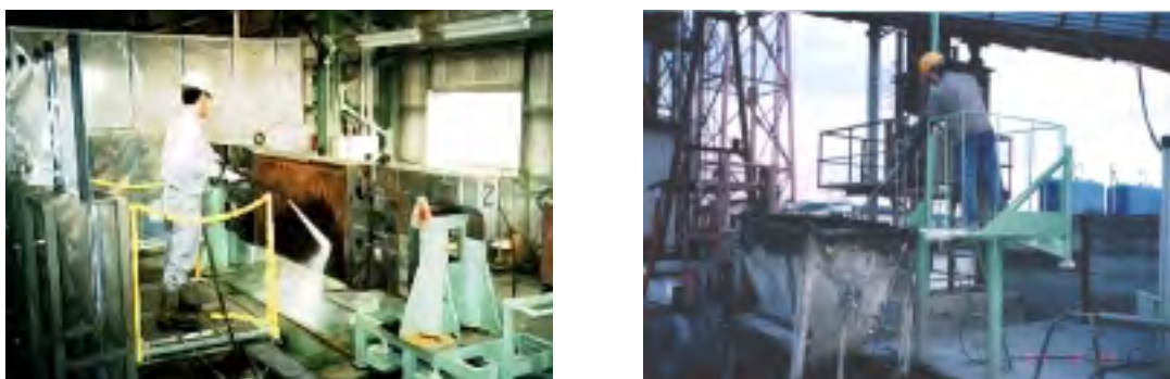
図6. 検索画面に表示された画像と実際のコンクリート注入機洗浄作業の画像の比較
