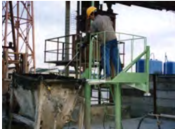
図4. 支援機器導入後の洗浄作業
