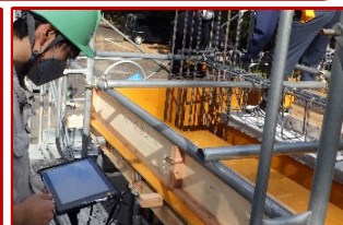
▲BIMモデル活用(施工状況の確認)
