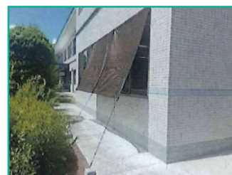
サンシェードの設置による室温上昇防止
